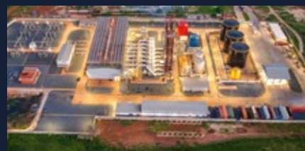
Centrale de Malicounda, Sénégal
